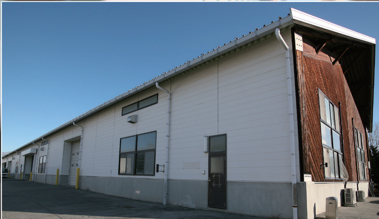
TSCフジケン事業部 山梨工場
