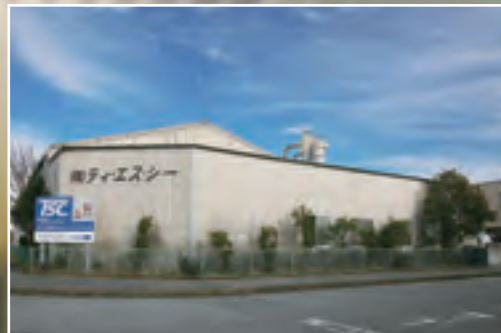
TSC本社工場
