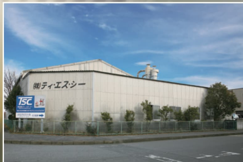
TSC本社工場
