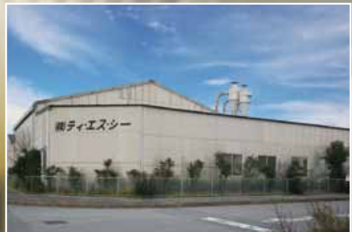
TSC本社工場
