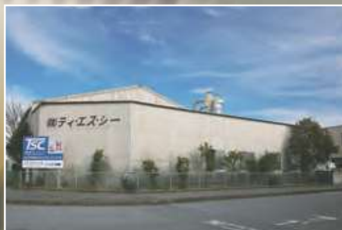
TSC本社工場
