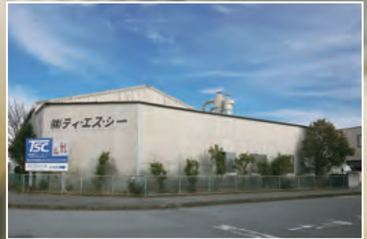
TSC本社工場
