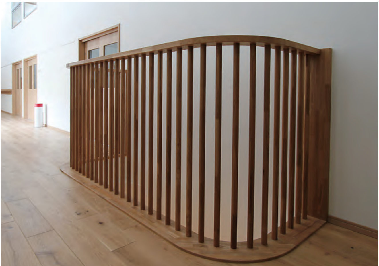
※この頁の写真は施工例です。 ※一部弊社製品ではないものが含まれます。
