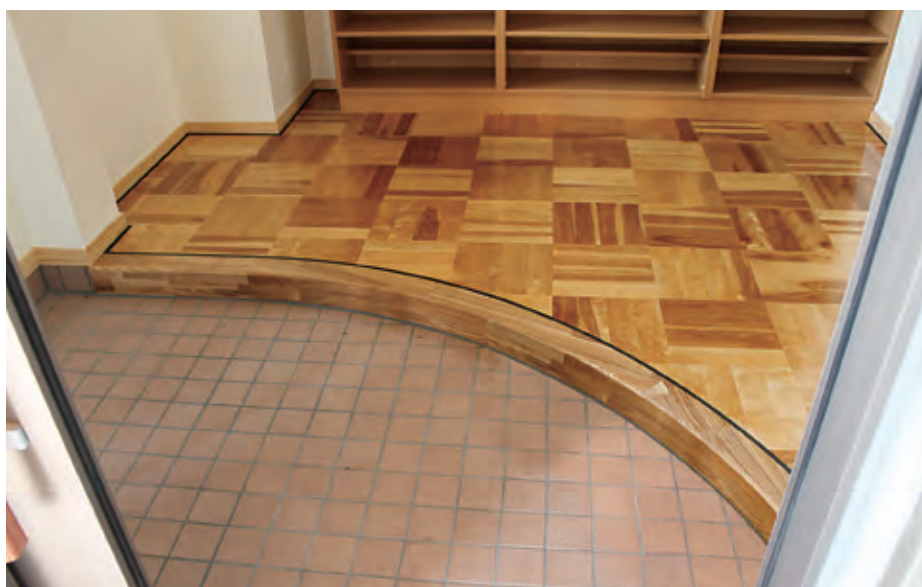
※この頁の写真は施工例です。 ※一部弊社製品ではないものが含まれます。
