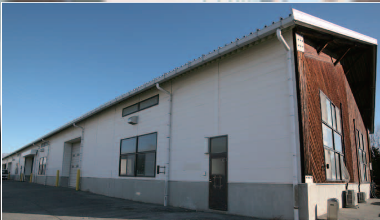
TSCフジケン事業部 山梨工場
