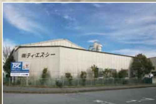
TSC本社工場
